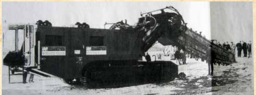
Über 4 Millionen DM investierte die Schöllnacher Erdbaufirma Sidla & Schönberger in die neue Fräs-, Misch- und Injektionsmaschine, die am Dienstag anlässlich der praktischen Vorführung bei den Fachleuten nachhaltigen Eindruck hinterlassen hat. (Fotos: Reinhold Baier)
