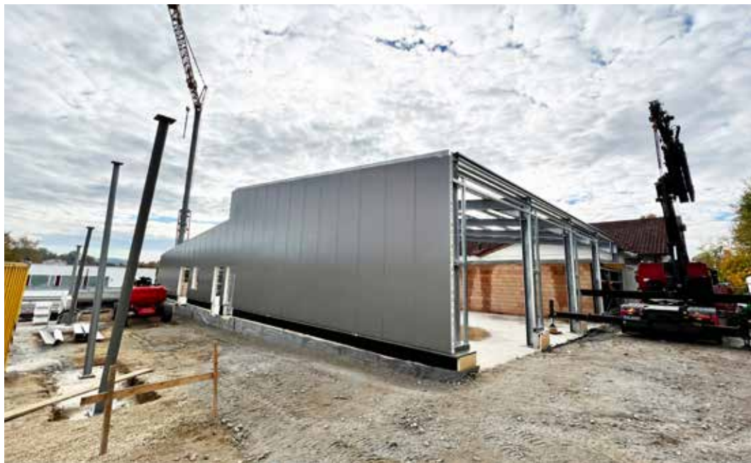
Die Arbeiten zur Erweiterung und Generalsanierung des Feuerwehrgerätehauses schreiten voran. Die Stahlhalle im hinteren Bereich des Geländes ist bereits fast fertig. Foto: sas-medien
